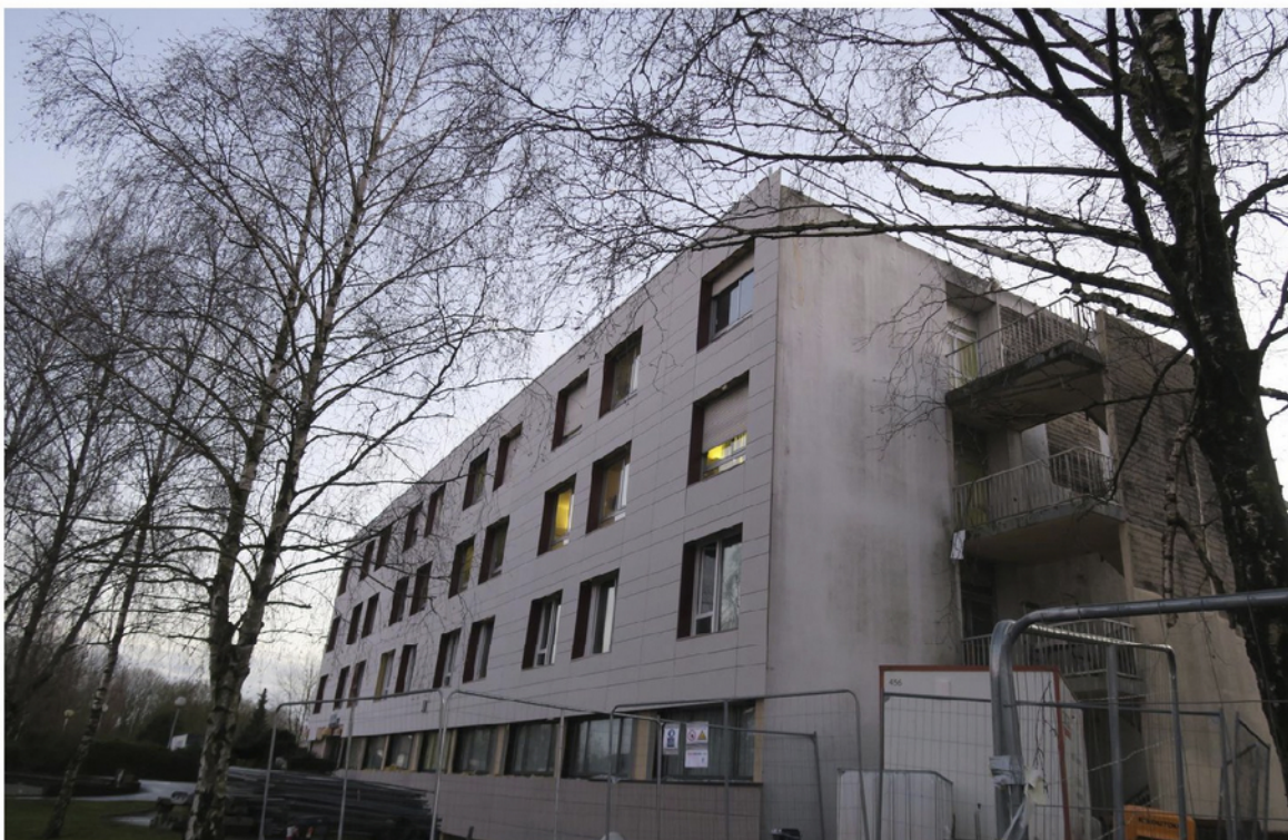
La réhabilitation du bâtiment Les Chênes a démarré. Le chantier a toutefois été retardé par des travaux de désamiantage.
