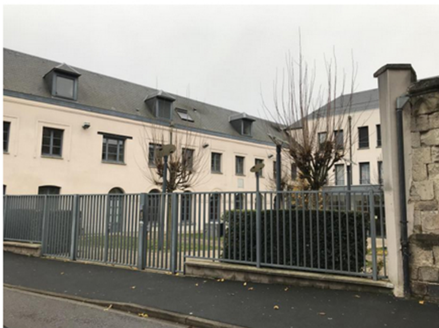
La résidence Vauban au Quesnoy accueillera l'ESPRESSO au premier trimestre. Elle aura une mission d'accompagnement des EHPAD de tout le Hainaut.
