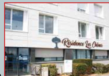
Un nouveau look pour le bâtiment Les Chênes
