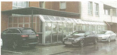
Le vérandas énergivore du bâtiment sera détruite pour une construction en dur, prévue en 2023.
