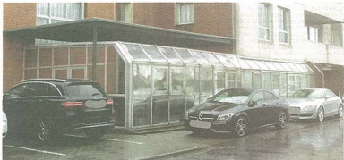
La véranda énergivore du bâtiment sera détruite pour une construction en dur, prévue en 2023.
